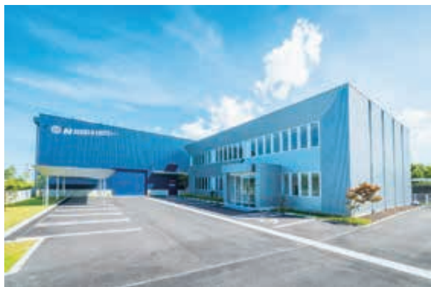
土成第2工場（令和5年2月完成）
