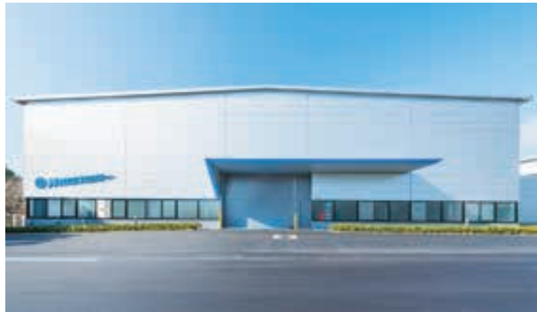
土成第1工場（第四期工場令和5年4月完成）
