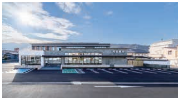
近年の施工事例(阿波銀行 佐古支店)
