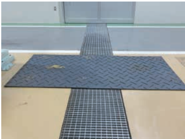
写真2 (新) 第三工場内の排水溝 (筆者撮影)
